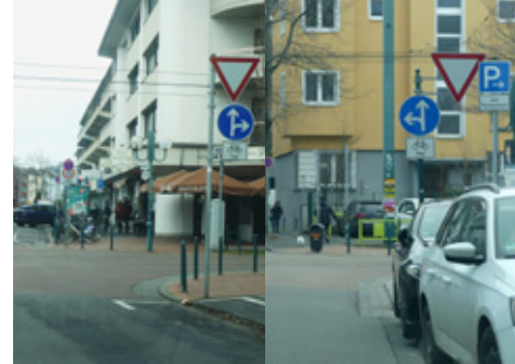
Über die Combahnstr., deren Baustelle auf der B 56 ab 15. Februar aufgelöst wird, ist die FBS aus 2 Richtungen anzufahren, um so in die Obere Wilhelmstr. zu gelangen.
