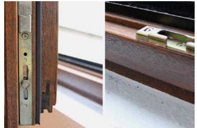
Pilzzapfen und weitere Sicherungen sind nachrüstbar.
