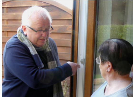
Besichtigung vor Ort und Hinweise zur Mängelbeseitigung durch den Spezialisten. Foto: H. Müller
